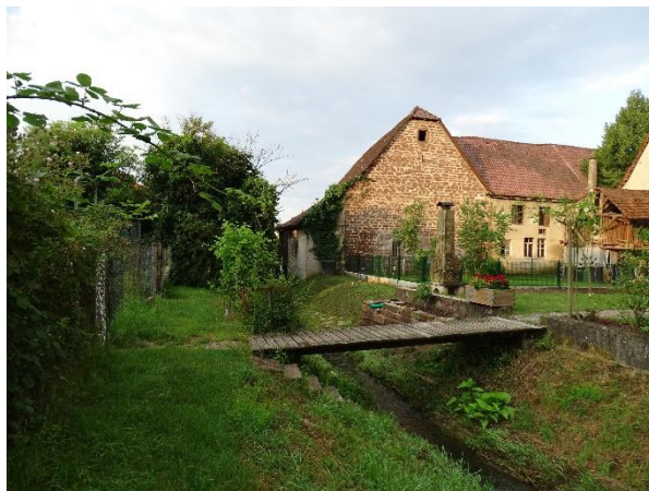
Abb. 5: Wohn- und Scheunengebäude südwestlich des Plangebiets
