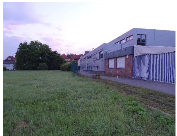
Abb. 6: Plangebiet mit der östlich anschließenden Turn- und Festhalle
