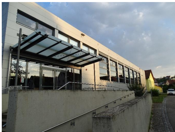
Abb. 7: Turn- und Festhalle aus Richtung Osten
